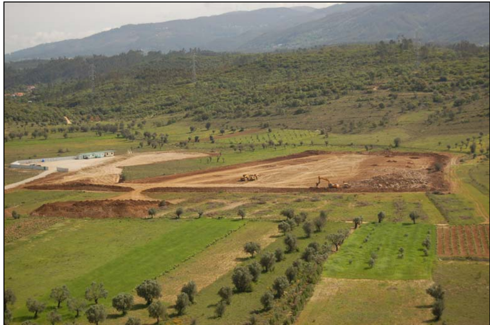
Vista geral do avanço dos trabalhos.
