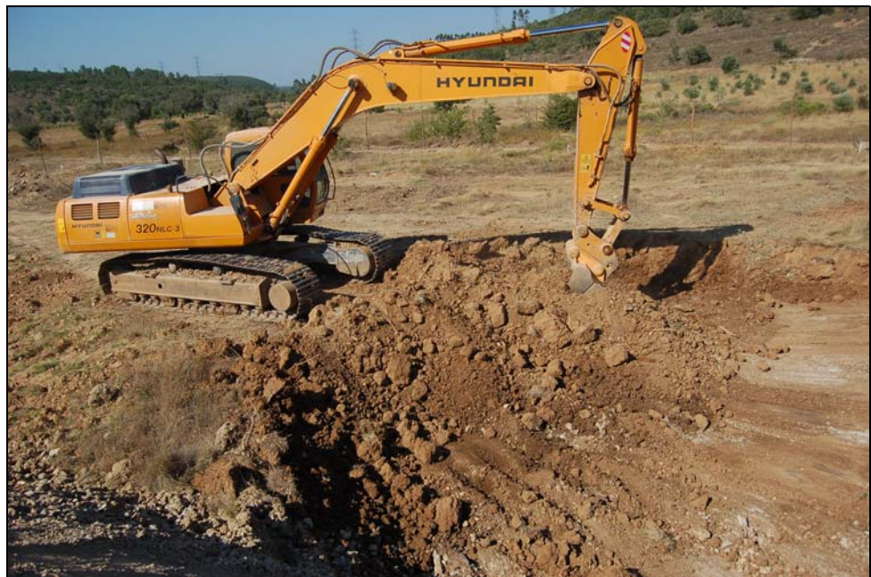
Pormenor de escavação no início do acesso.
