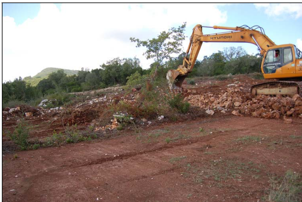
Pormenor de escavação junto ao final do acesso.
